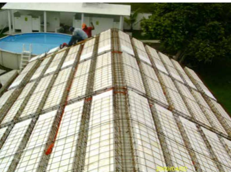
sin embargo, podemos fabricar con entre-ejes distintos, dependiendo del requerimiento de sobrecarga y de las dimensiones del claro de cada proyecto.
